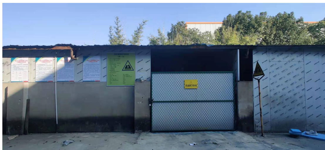
图 3-5 危险废物暂存场所
