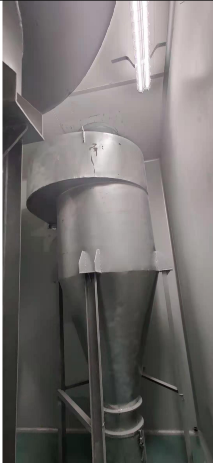
图 3-3 废气处理装置（旋风除尘器和布袋除尘器）
