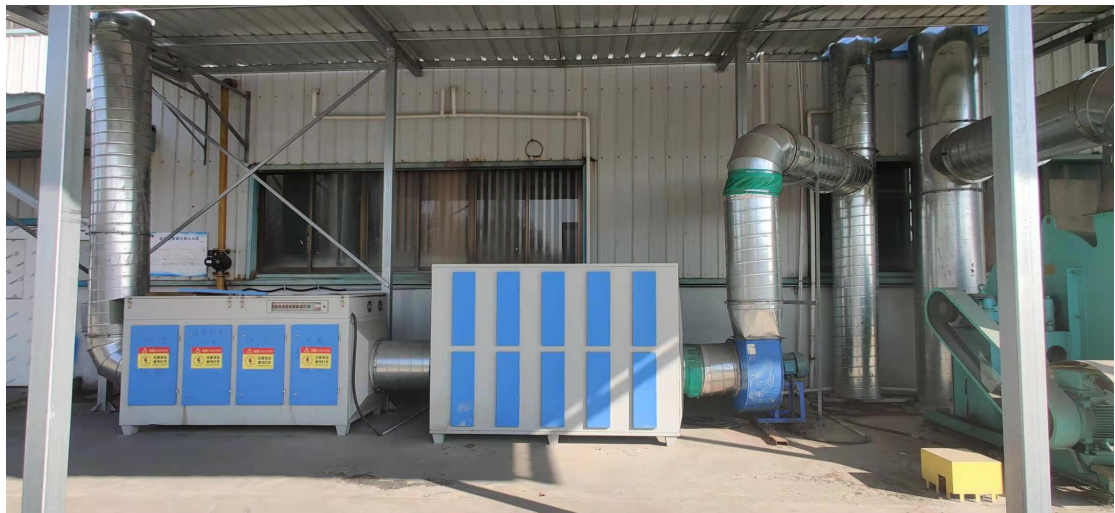
图 3-4 废气处理设施（光氧催化+活性炭装置）
